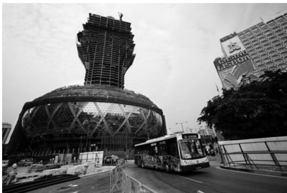
图3 建设中的新葡京赌场酒店 [23]
